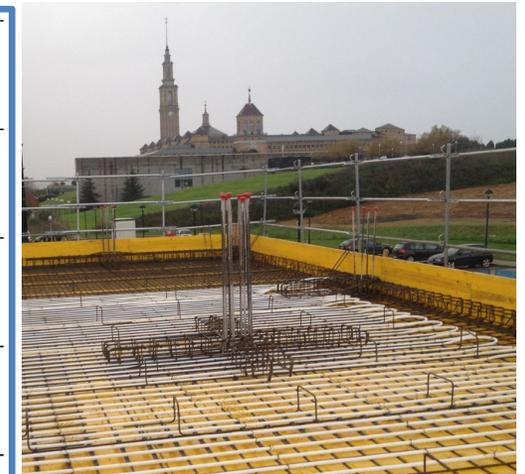
Ejecución losas de estructura termoactivadas
