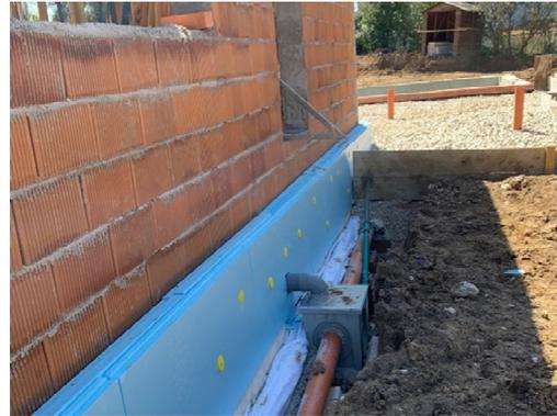
Figura 7. Fachadas. Aislamiento en arranque de fachada.
