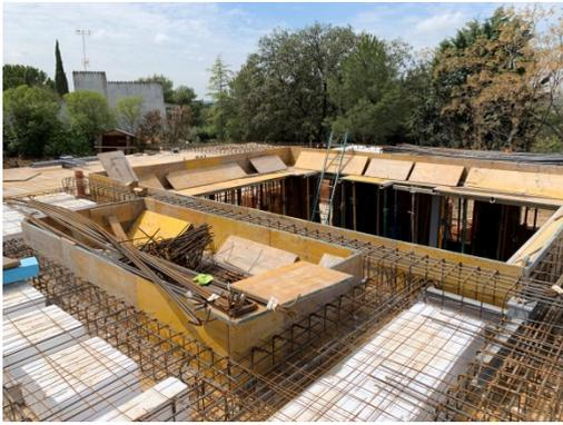
Figura 4. Estructura. Ejecución de forjado.
