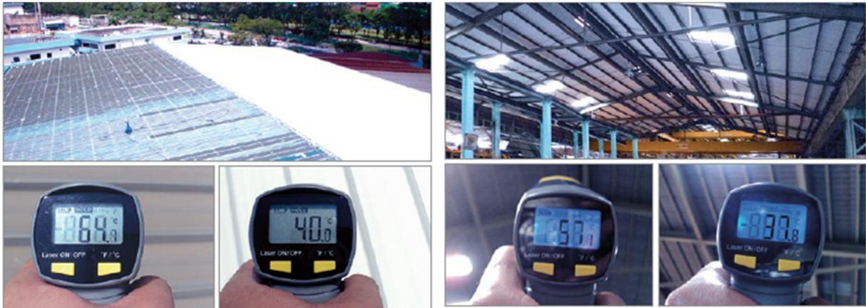
Figura 3. Nave industrial en Malasia. Exterior cubierta (antes-después): el Revestimiento de la cubierta redujo la temperatura de la superficie en 24,7°C. Figura 4. Interior cubierta (antes-después): la temperatura se redujo en 19,3°C. Resultado: mejores condiciones de trabajo ahorro de energía, reducción de costes de mantenimiento de la cubierta
