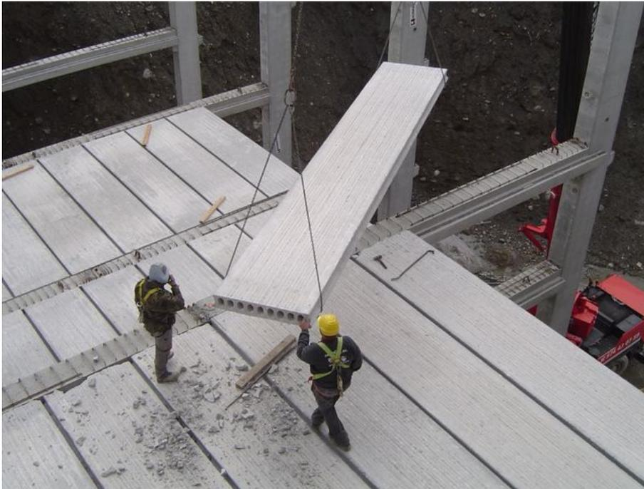
Figura 5. Colocación de placas alveolares, sistema constructivo con mayor grado de industrialización de los forjados y con una capacidad mayor de aprovechamiento energético.
