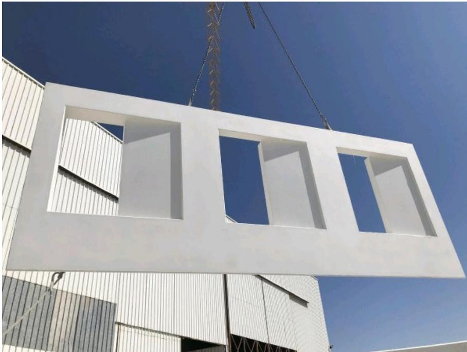
*Figura 6. Montaje de panel prefabricado de hormigón multiprestacional, cuyo diseño se realiza teniendo previstos los huecos de las ventanas.*
