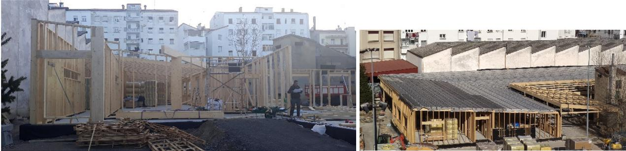
Figura 3. Estructura de Entramado Ligero y Cubierta del Edificio.
