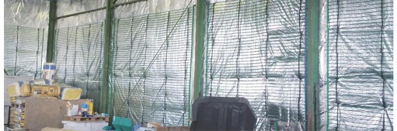
Figura 11. Instalación en la pared con lámina reflectora.
