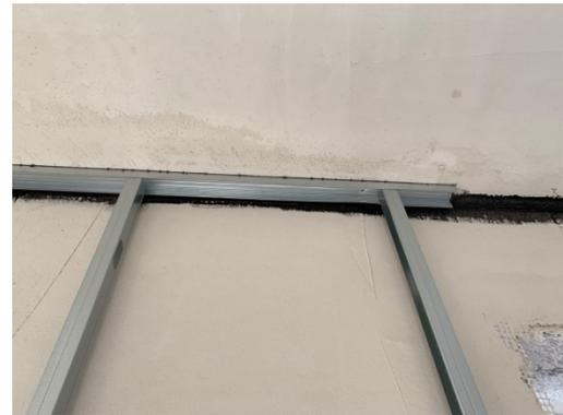
Figura 15. Detalle de refuerzos para evitar puentes térmicos.
