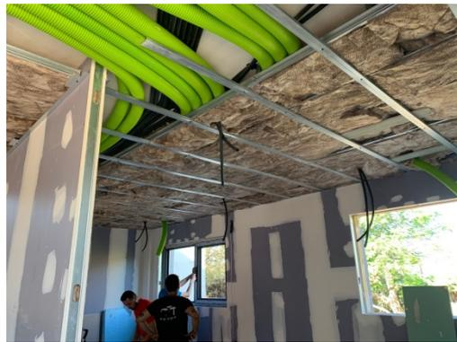
Figura 9. Cubierta. Aislamiento interior.
