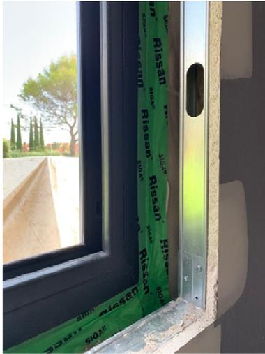
Figura 12. Carpintería exterior PVC de 6 cámaras.
