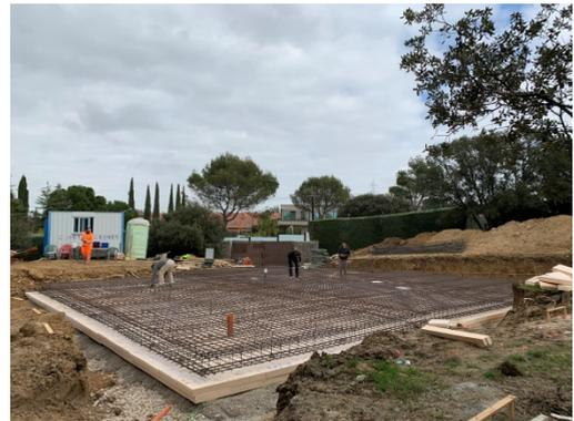
Figura 3. Cimentación. Ejecución de losa.
