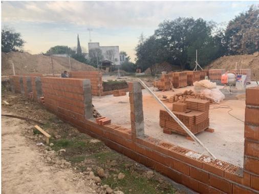
Figura 6. Fachadas. Arranque de fachada desde losa.
