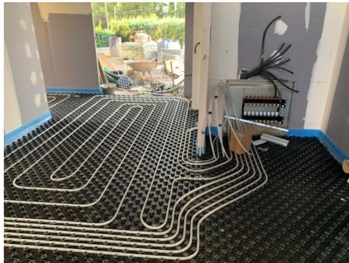
Figura 14. Suelo radiante conectado a aerotermia.
