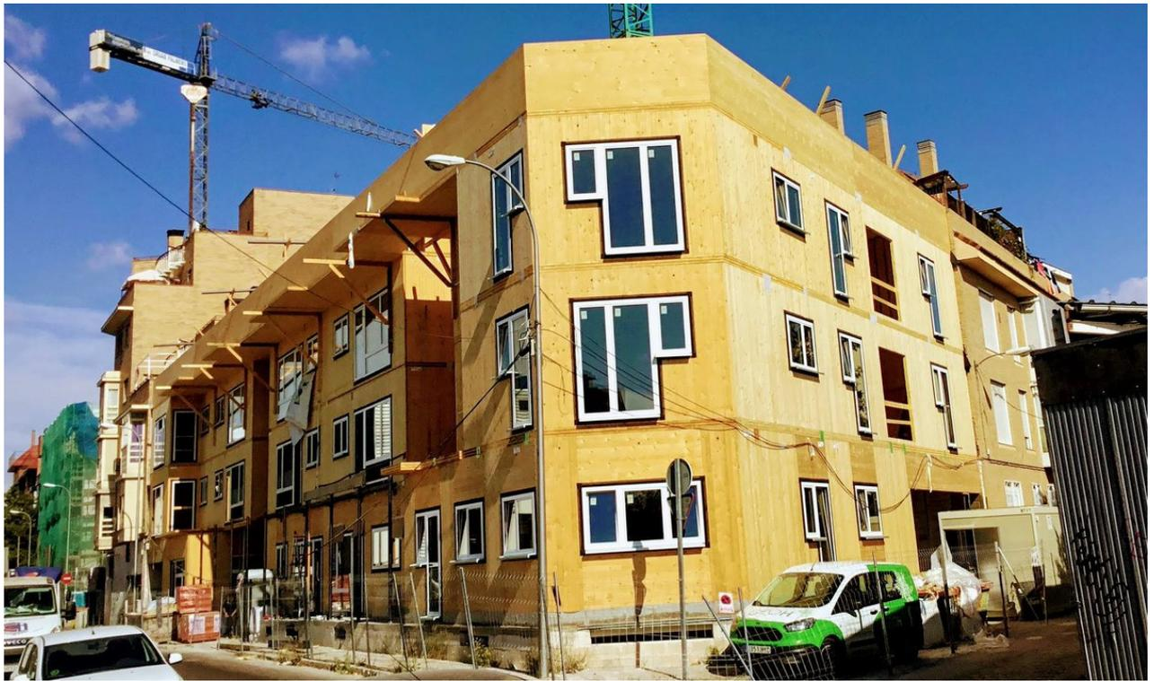
Figura 3. Vista general Entrepatrios- Las Carolinas estructura de madera CLT.
