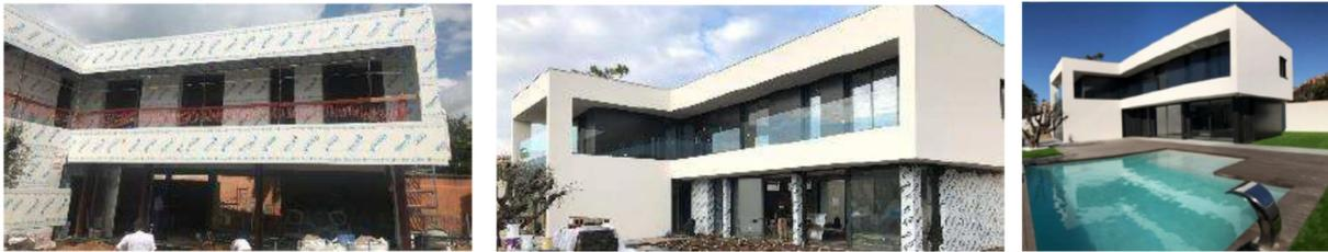
Figura 4. Ejemplos de PlacoTherm V<sup>®</sup>. Imágenes de Placo Saint Gobain.
