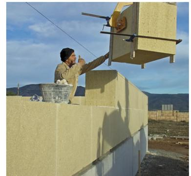
*Figura 1. Construcción de las oficinas de Rosal Stones con sillares de piedra maciza.*
