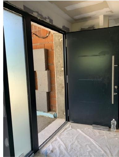
Figura 13. Puerta de entrada de aluminio certificada Passivhaus.
