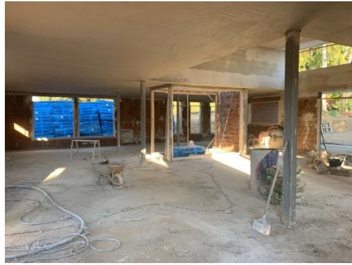
Figura 5. Estructura. Pilares metálicos y muros de carga.
