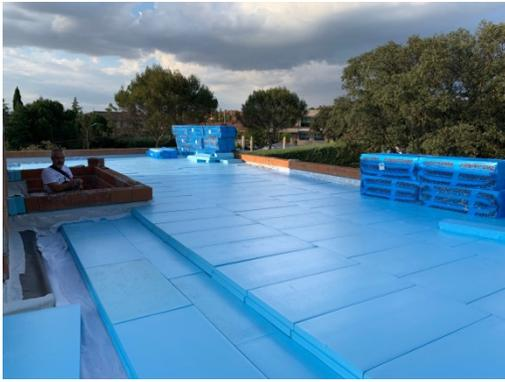
Figura 10. Aislamiento de cubierta.
