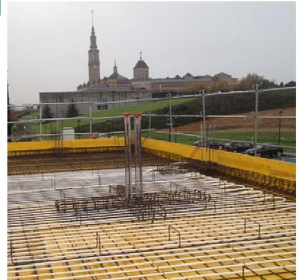
Figura 17. Panel de Control y monitorización de Producción. Figura 18. Fotografía ejecución lasas de estructura termoactivadas.
