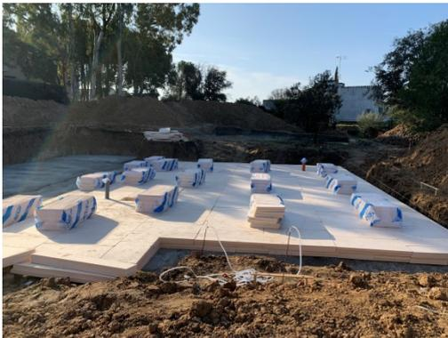
Figura 2. Cimentación. Colocación del XPS.
