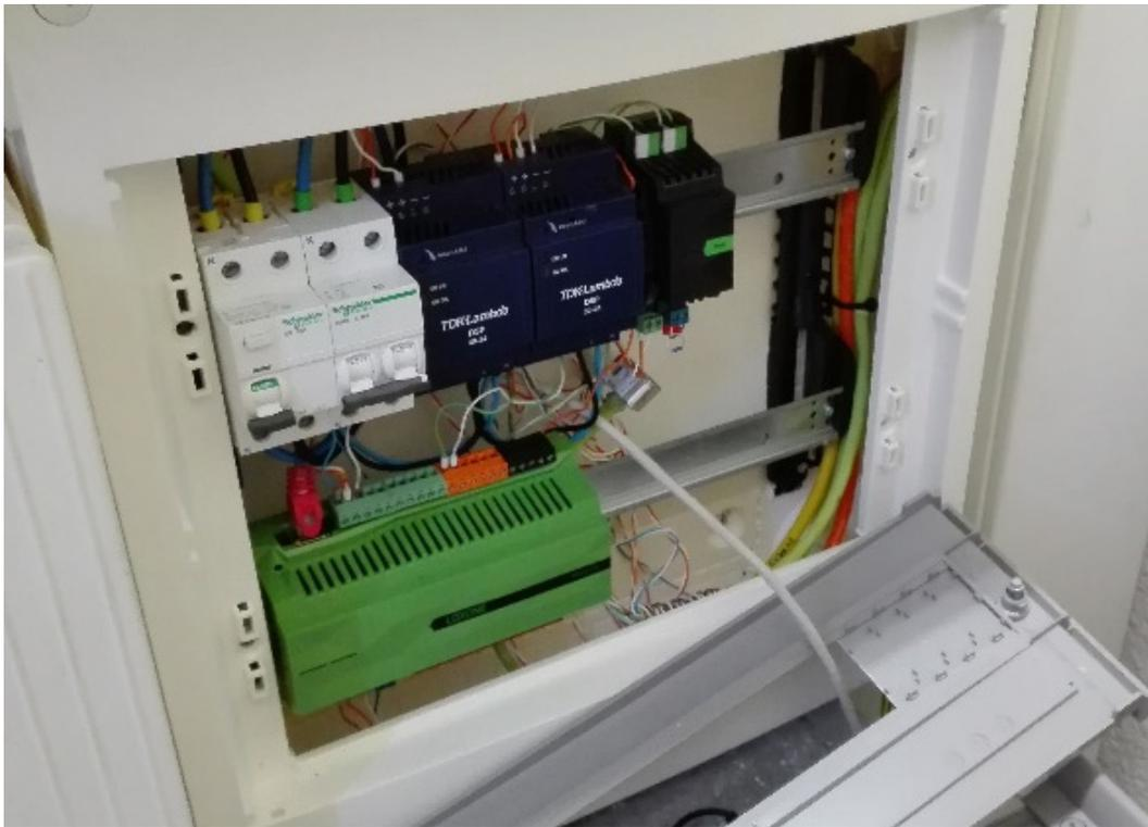
Imagen 2. Router Loxone - Gestor del sistema de monitoreo.
