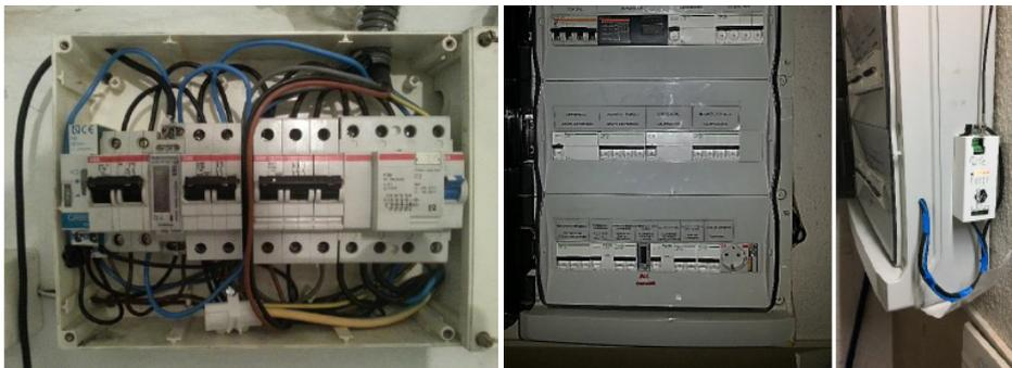
Figura 3. Medidores eléctricos en la torre y bloque para iluminación
