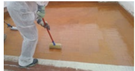
Aplicación de la imprimación MasterTop P 682 para soportes vitrificados.
