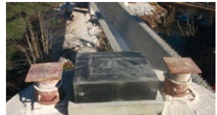
Adherir la pletina o el elemento en general ejerciendo presión para asegurar el pleno contacto con el adhesivo.
