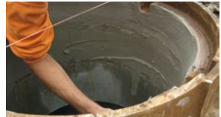
Aplicar MasterEmaco T 1100 TIX o MasterEmaco T 300 LT/HT con llana o paleta.
