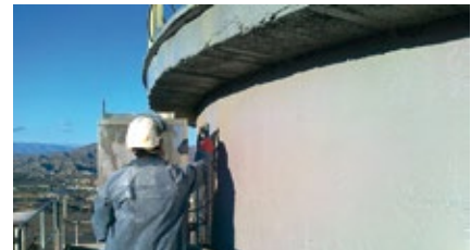
Aplicación del MasterProtect 320/325 EL por proyección con airless.
