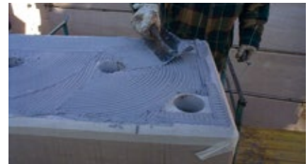
Aplicación con espátula del adhesivo epoxi en el soporte.
