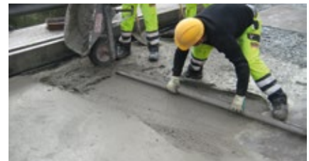
Rastrelar MasterEmaco T 1400 FR sobre pavimento de hormigón.
