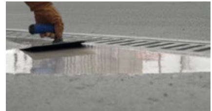
Nivelar con MasterEmaco T 1200 PG sobre el soporte humedecido.
