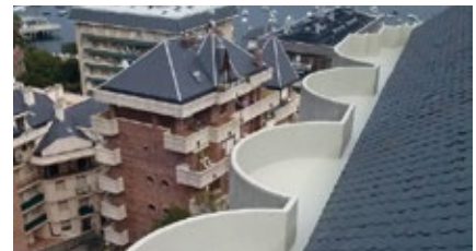
Segunda capa de membrana de impermeabilización MasterSeal M 251 pigmentada o transparente.
