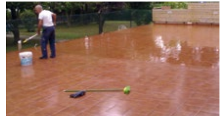
Primera capa de membrana de impermeabilización MasterSeal M 251 pigmentada o transparente con rodillo de pelo corto.
