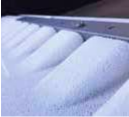
Detalle de instalación de rastrel
