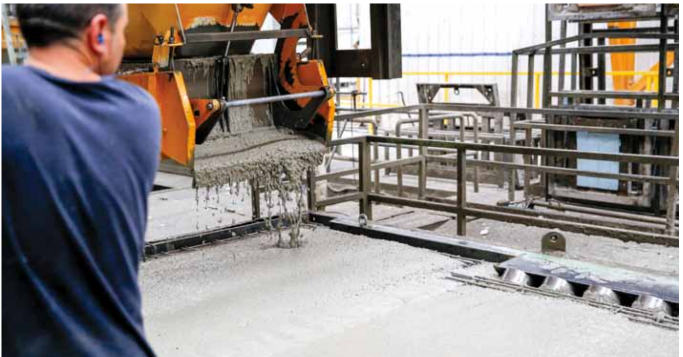
MasterFiber 249 Hormigón prefabricado. Uniblock, Toledo
