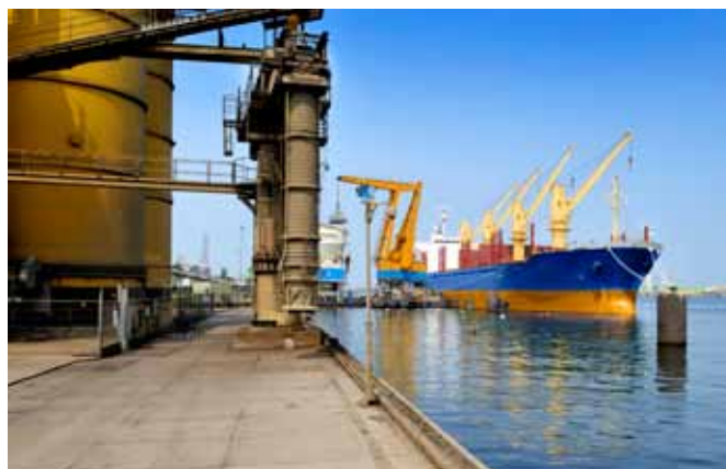
Puertos y otras estructuras marítimas como muelles y espigones, en especial en las zonas de impacto directo con las olas.
