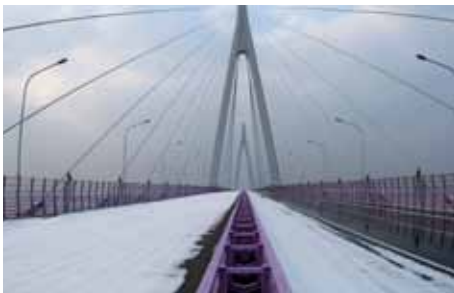
Puente sobre la Bahía de Hangzhou, (China).
