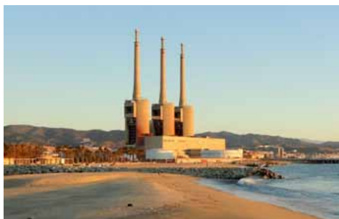
Complejos industriales donde se usa agua de mar en el sistema de refrigeración.
