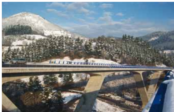
Estructuras en zonas frías expuestas al uso frecuente de sales de deshielo.
