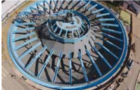
Decantador de la ETAP el Atabal, Málaga (España).
