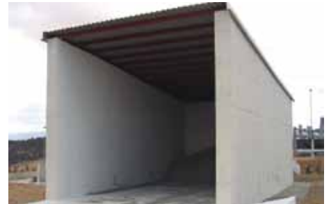
Centro de Conservación y Explotación de la Red de Carreteras del Estado, Teruel (España).
