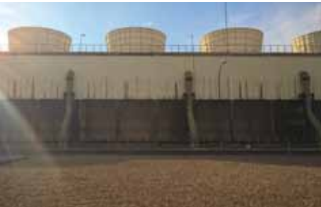
Torres de refrigeración de Gas Natural, Sagunto (España).
