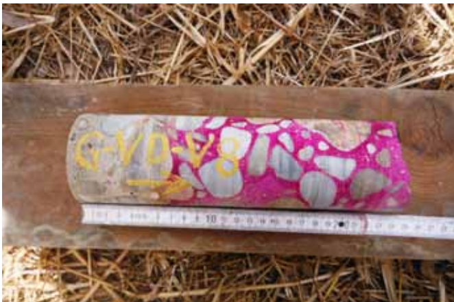
Test de la fenolftaleína para determinar el frente de carbonatación. El hormigón que no se tiñe de rosa al aplicar el indicador está afectado por carbonatación
