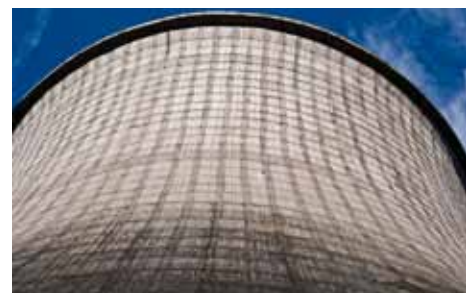
Torres de Refrigeración, Beringen (Bélgica).
