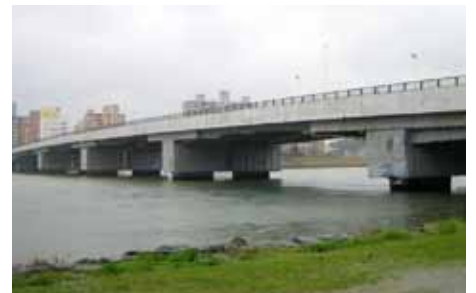
Puente Tachibana, (Japón).
