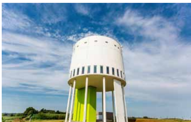
Instalaciones industriales de hormigón armado expuestas a la intemperie especialmente si hay exposición a cloruros.
