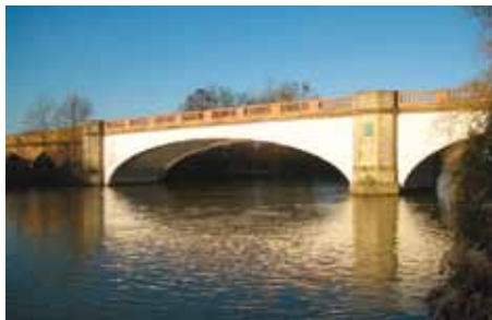
Puente Albert Bridge, Londres (Inglaterra).
