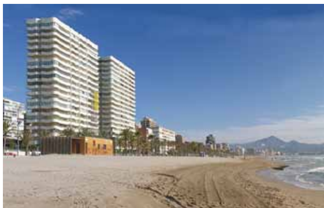
Edificios residenciales y estructuras de hormigón armado expuestas al ambiente marino.
