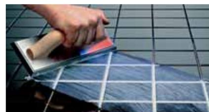
A las 3,5 horas de la aplicación del adhesivo cementoso ó 24 horas en el caso del adhesivo epoxy, proceder al rejuntado de la cerámica.
