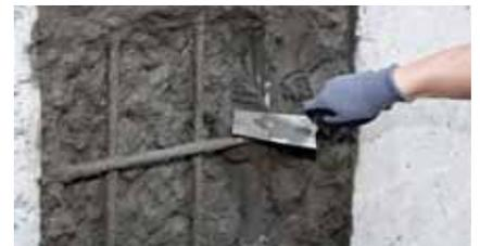
Aplicar el mortero de reparación MasterEmaco S con llana, paleta, por proyección o por vertido.
