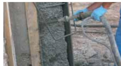
Aplicar el mortero de reparación MasterEmaco S/N con llana, paleta, por proyección o por vertido. Ver sistemas de reparación de hormigón en páginas 10, 12.
