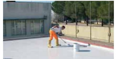
Aplicar la membrana impermeabilizante en dos manos mediante rodillo de pelo corto.
