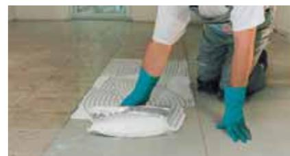
Para aplicaciones convencionales, aplicar el adhesivo por simple encolado. Para aplicaciones en exteriores, con fuertes agresiones químicas o mecánicas y/o zonas con humedad permanente, aplicar el adhesivo por doble encolado.
