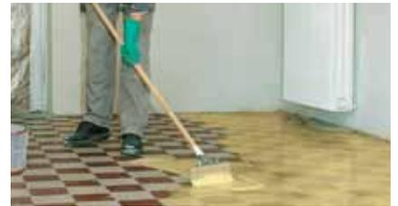
Sólo en el caso de soportes especiales (por ej. soportes muy absorbentes o no absorbentes), aplicar la imprimación MasterTile P 303 con brocha o rodillo.
