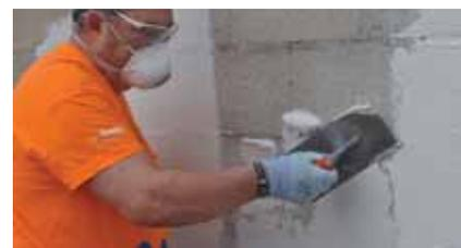
Aplicación de mortero de impermeabilización MasterSeal por proyección, brocha o con llana.
