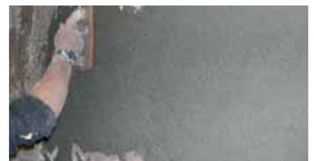
Aplicar el mortero de acabado MasterEmaco N 5100 FC con llana o paleta sobre el mortero estructural (ver Sistema IB-2 "Reparación de hormigón cosmética").
