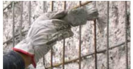
Aplicar protector de corrosión MasterEmaco P 2000 BP sobre las armaduras.
