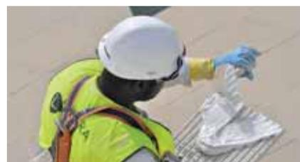
Mezclar el contenido del saco con el agua de amasado indicada, con taladro provisto de agitador. Aplicar el adhesivo amasado por doble encolado.
