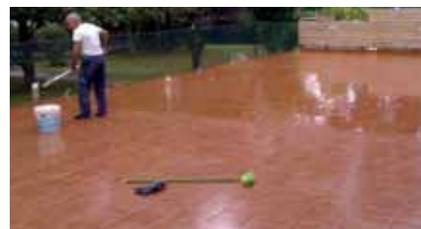
Primera capa de membrana de impermeabilización MasterSeal M 251 pigmentada o transparente.
