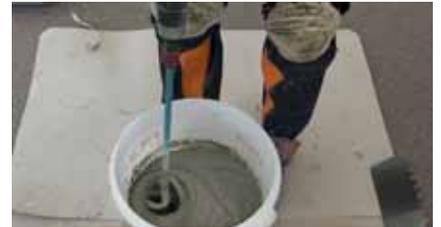
Mezclar el contenido del saco con el agua de amasado indicada, mediante taladro provisto de agitador.
