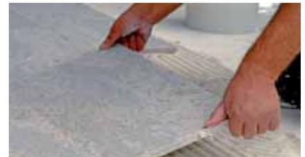
Colocar las piezas sobre el adhesivo aplicado ejerciendo una ligera presión para asegurar el completo contacto entre la pieza y el adhesivo. Es recomendable humedecer las piezas previamente a su colocación.
