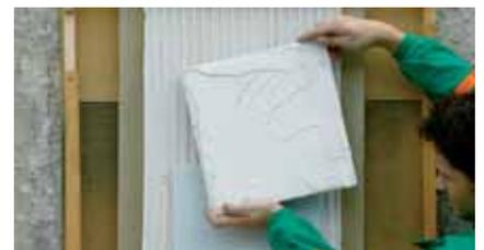
Mezclar el adhesivo de cerámica con taladro provisto de agitador. Aplicación del adhesivo amasado por doble encolado.
