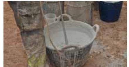
Mezclar el contenido del saco con el agua de amasado indicada, con taladro provisto de agitador. Para aplicaciones en fachadas, añadir durante el amasado del adhesivo, el aditivo MasterTile A 200.
