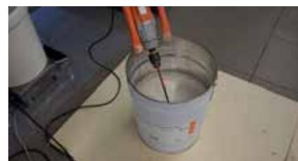
Mezclado de la imprimación bicomponente. Mezclar con taladro mecánico provisto de agitador a muy bajas revoluciones (aprox. 300 rpm) durante al menos 3 minutos.
