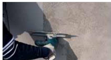
Aplicación de mortero cosmético MasterEmaco N 245 FC en el sistema de deshumificación de muros.
