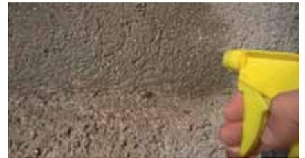
Antes de aplicar el mortero de reparación cosmética, humedecer el soporte sin encharcar (húmedo per mate).
