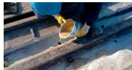
Para anclajes o fijaciones verticales, aplicar el producto de relleno/anclaje y disponer el elemento a fijar asegurando el pleno contacto con el producto aplicado.
