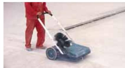
Preparar el soporte con medios mecánicos para eliminar la capa superficial del hormigón, con un lijado o por granallado.
