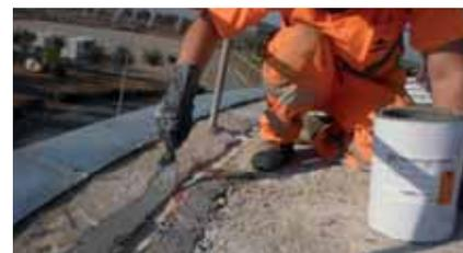
Deberá aplicarse una capa fina de MasterSeal 933 a modo de capa de contacto para facilitar la adherencia sobre el soporte.
