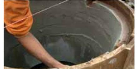
Aplicar MasterEmaco T 1100 TIX o MasterEmaco T 300 LT/HT con llana o paleta.
