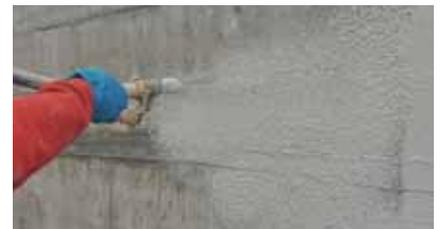
Mezclar el mortero de impermeabilización con taladro provisto de agitador. Aplicar el mortero amasado por proyección o mediante rodillo en todo el vaso de la piscina.
