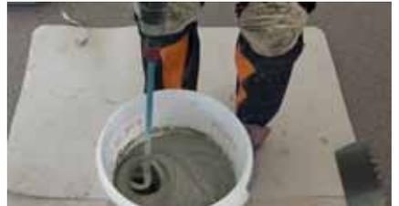
Mezclar el contenido del saco con el agua de amasado indicada, con taladro provisto de agitador.
