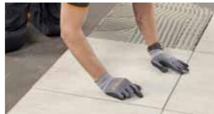
Colocar las piezas cerámicas sobre el adhesivo aplicado ejerciendo una ligera presión. En paramentos verticales puede ser necesario fijar/sujetar las piezas colocadas durante 24 horas.
