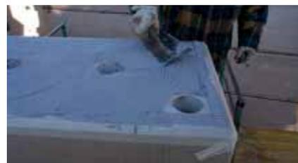
Aplicación con paleta del adhesivo epoxi en el soporte.
