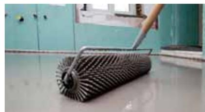
En el caso de los morteros autonivelantes, proceder al desaireando pasando sobre el material fresco con un rodillo de púas.
