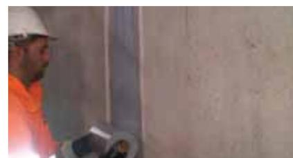
Situar la banda de sellado MasterSeal 930 en su localización definitiva de modo que el lateral de la banda quede embebido en el adhesivo.
