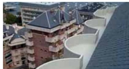
Segunda capa de membrana de impermeabilización MasterSeal M 251 pigmentada o transparente.
