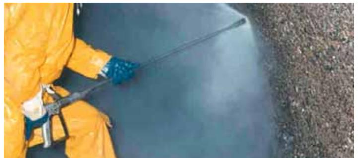
Para evitar espesores de aplicación por debajo de los valores mínimos que se muestran, los bordes donde el hormigón ha sido eliminado deben cortarse en un ángulo de al menos  $90^\circ$ . Además, los bordes deben ser correctamente rugosos con el fin de asegurar la unión mecánica entre el hormigón original y el material de reparación. La resistencia media del soporte debe ser mayor que  $1,5 \text{ N/mm}^2$  y el valor individual más bajo no debe ser inferior a  $1,0 \text{ N/mm}^2$ .
