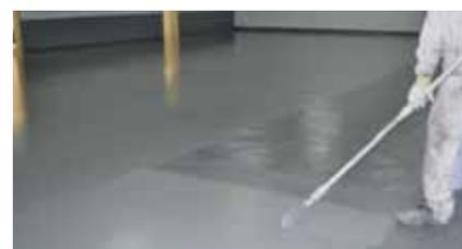
Aplicación del recubrimiento – pintura mediante rodillo de microfibra. Aplicar al menos 2 manos. Transitable tras 24 horas desde la aplicación.
