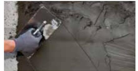
En caso de ser necesario, eliminar previamente restos de suciedad y partes sueltas, regularizar y limpiar hasta obtener una superficie suficientemente regular. Reparar las zonas con daños si es el caso (ver los sistemas acerca de reparación de hormigón en las páginas 12 y 14).
