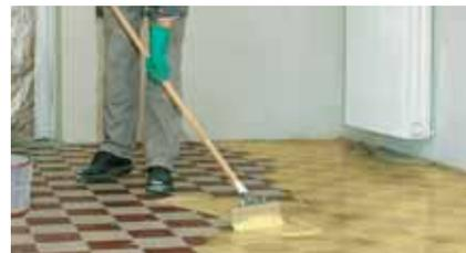
En caso de ser necesario, eliminar previamente restos de suciedad y partes sueltas, regularizar y limpiar hasta obtener una superficie adecuada. Sólo en el caso de soportes especiales (por ej. Soportes muy absorbentes o no absorbentes), aplicar la imprimación MasterTile P 303.
