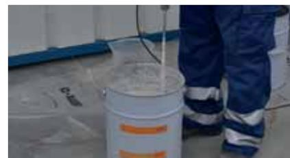
Mezclado con taladro mecánico provisto de agitador a bajas revoluciones hasta conseguir una mezcla homogénea.
