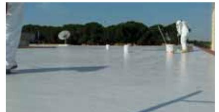
Para el caso de MasterSeal M 640, aplicar la capa de sellado con rodillo, brocha o pistola air-less entre 12 y 36 horas tras la aplicación de la membrana.
