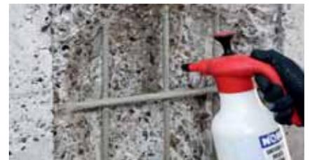
Si no se emplea puente de unión, humedecer el soporte sin encharcar (húmedo pero mate) antes de aplicar el mortero.
