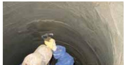
Aplicación del mortero monocomponente, impermeable y resistente a sulfatos MasterSeal 531, mediante brocha, rodillo, por proyección o a llana.
