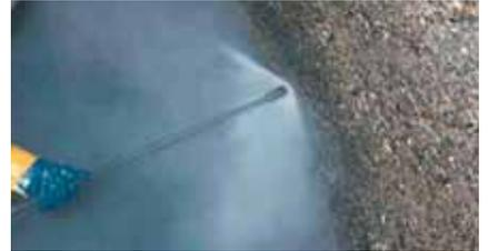
Eliminar las partes de hormigón dañado, hasta obtener un soporte sano, firme y libre de sustancias que dificulten la adherencia.
