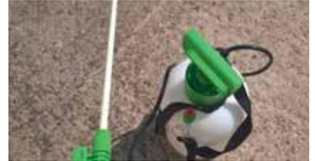
Antes de la aplicación del mortero, humedecer el soporte con agua sin encharcar.
