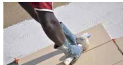
Colocar las piezas cerámicas sobre el adhesivo aplicado ejerciendo una ligera presión, asegurando el completo contacto de la pieza con el adhesivo.
