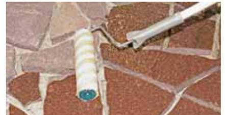
A las 24 horas de la aplicación del adhesivo, proteger los adoquines.
