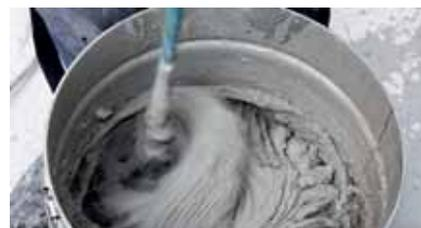
Mezclado del mortero con el agua de amasado indicada con taladro provisto de agitador.
