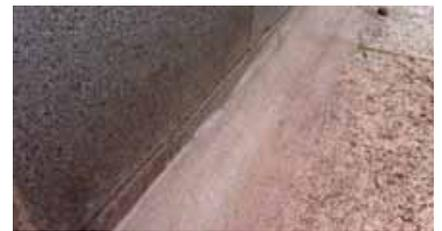
Confeccionar las medias cañas y resolución previa de detalles antes de aplicar el mortero impermeabilizante.
