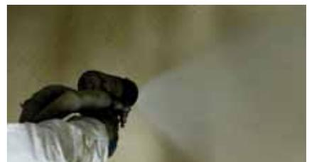
Aplicación por proyección o con brocha o rodillo de la membrana sintética MasterSeal M 336.
