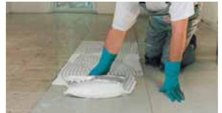
Para aplicaciones convencionales, aplicar el adhesivo por simple encolado mediante llana dentada. En exteriores y/o zonas con humedad permanente, aplicar el adhesivo por doble encolado.
