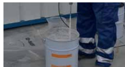
Mezclado del recubrimiento – pintura bicomponente. Mezclar con taladro mecánico provisto de agitador a muy bajas revoluciones (aprox. 300 rpm) durante al menos 3 minutos.
