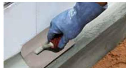
Confeción de medias cañas con MasterEmaco N para crear una continuidad en la impermeabilización de la estructura.
