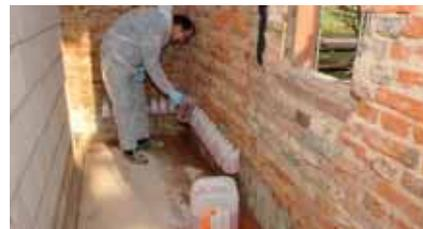
Eliminar las partes de mortero sueltas hasta obtener un soporte sano, firme y libre de sustancias y polvo que dificulten la adherencia.
