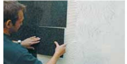
Para aplicaciones convencionales, aplicar el adhesivo por simple encolado. Para aplicaciones en exteriores y/o zonas con humedad permanente, aplicar el adhesivo por doble encolado.
