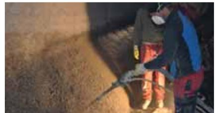
Aplicar el mortero de reparación MasterEmaco S con llana, paleta, por proyección o por vertido. Ver sistema de reparación páginas 10 y 12.
