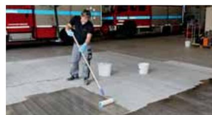
Aplicación de la imprimación sobre el soporte mediante rodillo.
