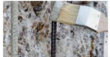
Aplicar el puente de unión / protector de armaduras MasterEmaco P sobre las armaduras y sobre el soporte. Aplicar el mortero antes de que el puente de unión esté seco al tacto.
