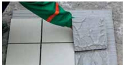
Para aplicaciones convencionales, aplicar el adhesivo por simple encolado, con llana dentada. En exteriores y/o zonas con humedad permanente, aplicar el adhesivo por doble encolado.
