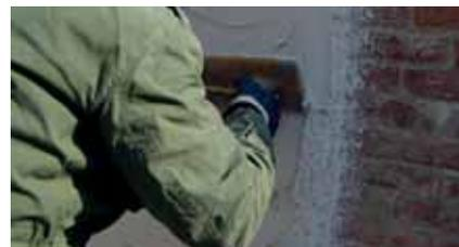
Aplicación del mortero deshumificador MasterEmaco N 235 en muros de albañilería.
