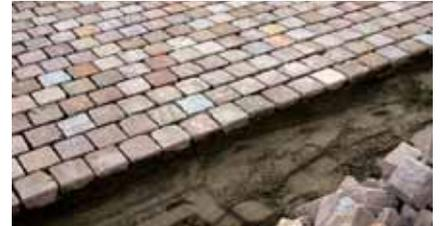
Aplicar una cama de adhesivo y proceder a la colocación de los adoquines.
