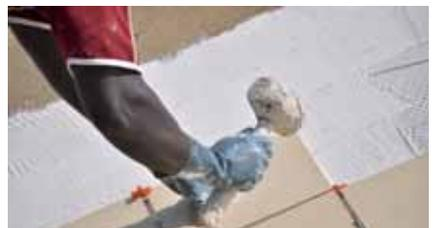
Colocar las piezas cerámicas sobre el adhesivo aplicado ejerciendo una ligera presión, asegurando el completo contacto entre la pieza y el adhesivo.
