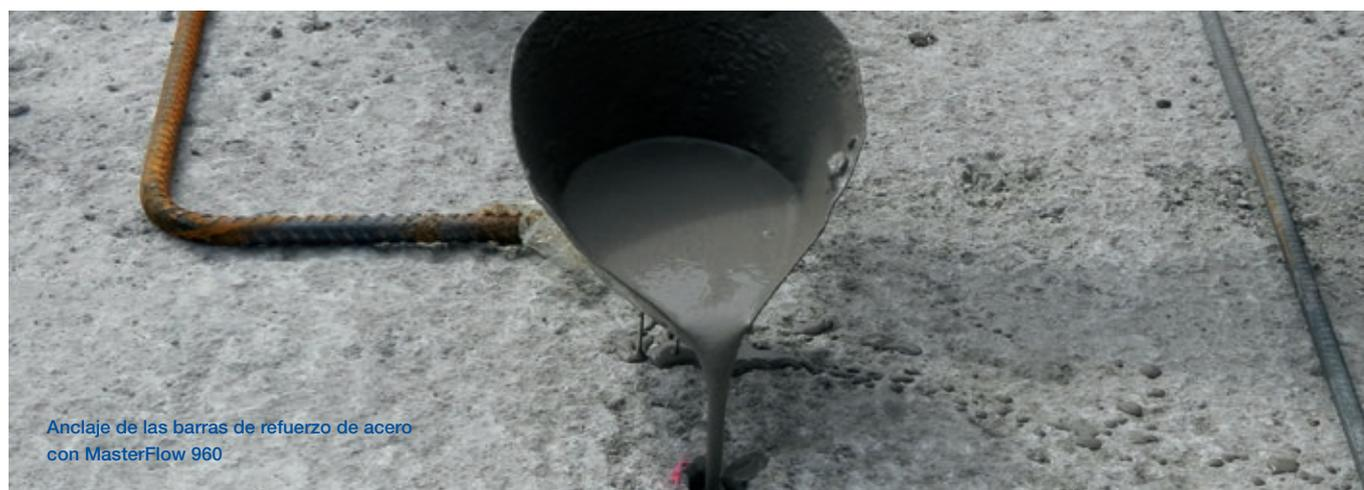
Anclaje de las barras de refuerzo de acero con MasterFlow 960
