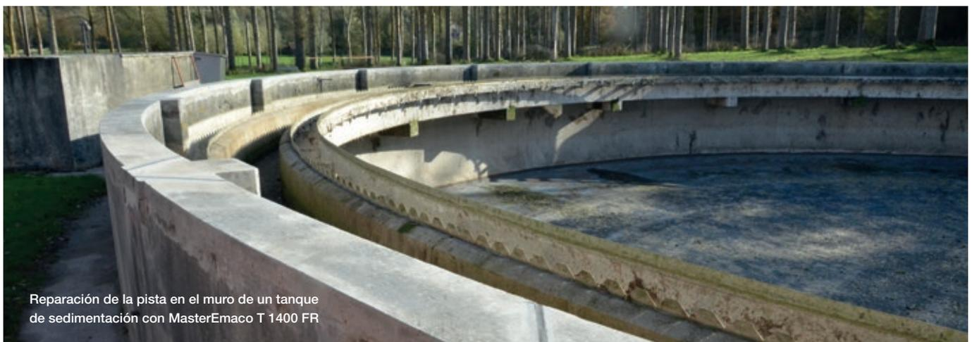
Reparación de la pista en el muro de un tanque de sedimentación con MasterEmaco T 1400 FR
