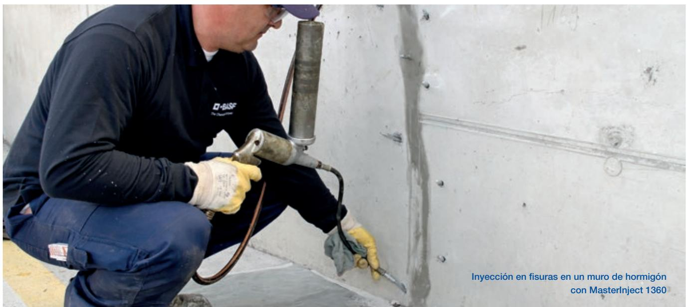
Inyección en fisuras en un muro de hormigón con MasterInject 1360
