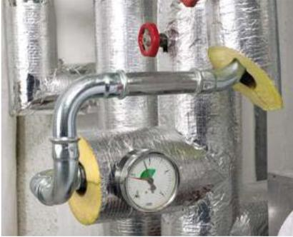
Las tuberías de agua caliente se utilizan comúnmente para dar servicio de calefacción y ACS. A pesar que la temperatura dentro de este tipo de tuberías no es muy alta, si la longitud es larga, se puede perder en la distribución una gran cantidad de calor si no está correctamente aislado.
