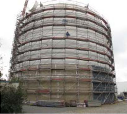
Los combustibles fósiles deben estar calientes para su manipulación y almacenamiento. El combustible pesado está normalmente a una temperatura de 50 grados o más y debe ser transportado y conservado a esta temperatura. Los tanques y las tuberías deben estar aisladas para mantener estas mínimas temperaturas.
