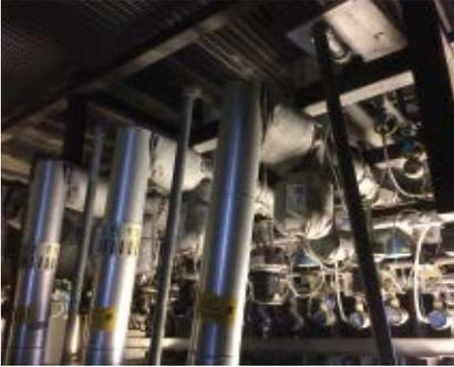
Una colchoneta aislada es un encapsulado desmontable relleno de aislante para aquellos equipos que necesiten revisiones periódicas de mantenimiento. Contiene una cubierta termo-resistente la cual protege y retiene el aislante dentro de él. Con este sistema se pueden aislar bridas, válvulas, bombas, juntas de expansión, e incluso equipos completos.
