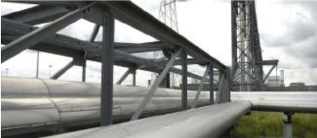
La calefacción de distrito es un sistema de distribución de calor generado en una locación centralizada a través de un sistema de tuberías aisladas para requerimientos residenciales y comerciales como calefacción de edificios y de agua caliente sanitaria. El calor es obtenido desde una planta de cogeneración quemando combustibles fósiles o por biomasa.
