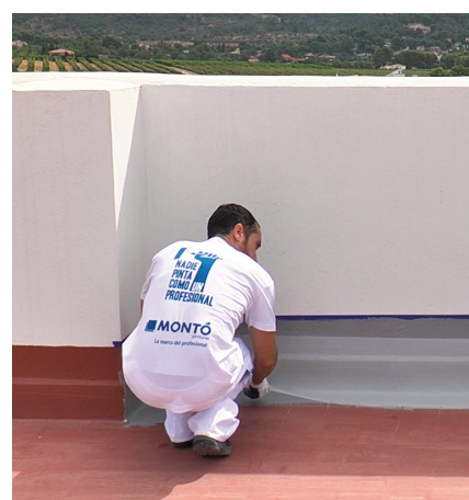
Refuerzo de puntos singulares
