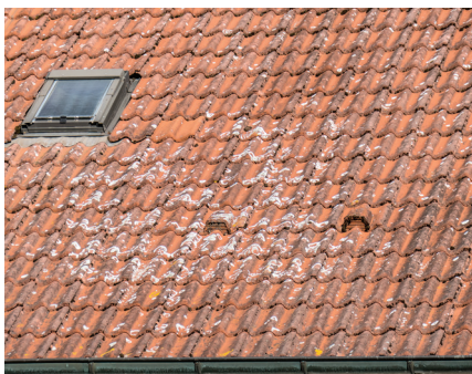
Humedad por filtración/tejado
