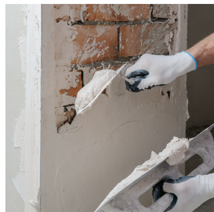
Renovación con revoco transpirable
