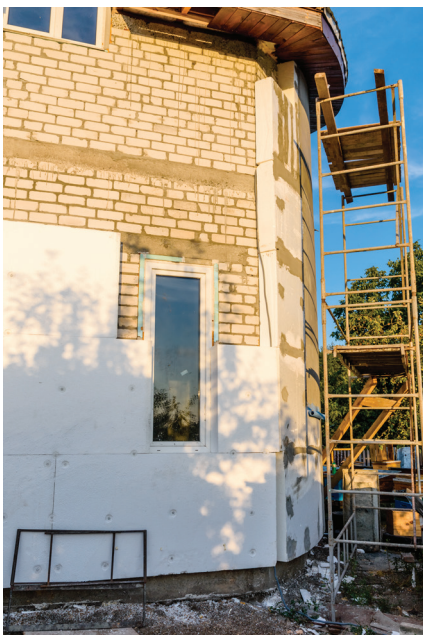
Sistema Aislamiento Térmico Exterior (SATE)
