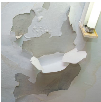
Humedad por filtración/gotera
