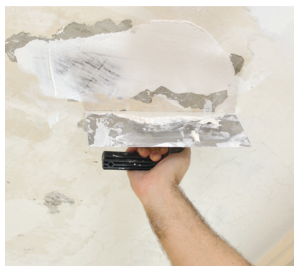
Relleno de grietas
