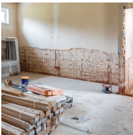
Muro visto para evaporar
