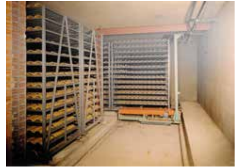
Instalación de secadero, molienda, moldeo y extrusión Installation of dryer, grinding, molding and extrusion areas
