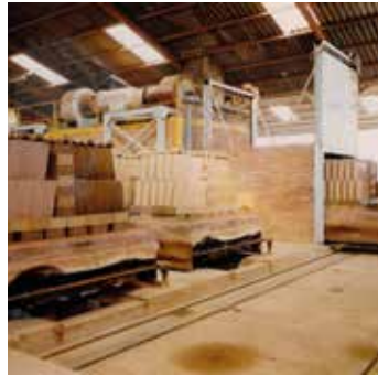
Instalación del primer horno túnel Installation of the first tunnel kiln
