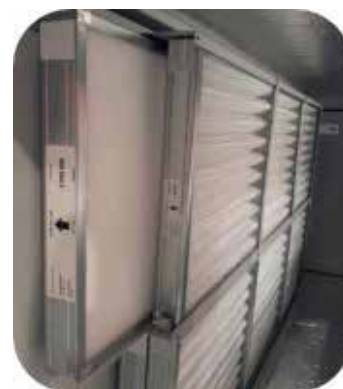
Sistema de filtración G4+F7
