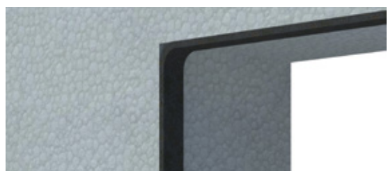
CINTA DE EXPANSIÓN APLICACIÓN INCORRECTA
