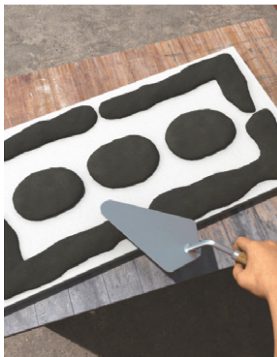
Método de Cordón de Mortero
