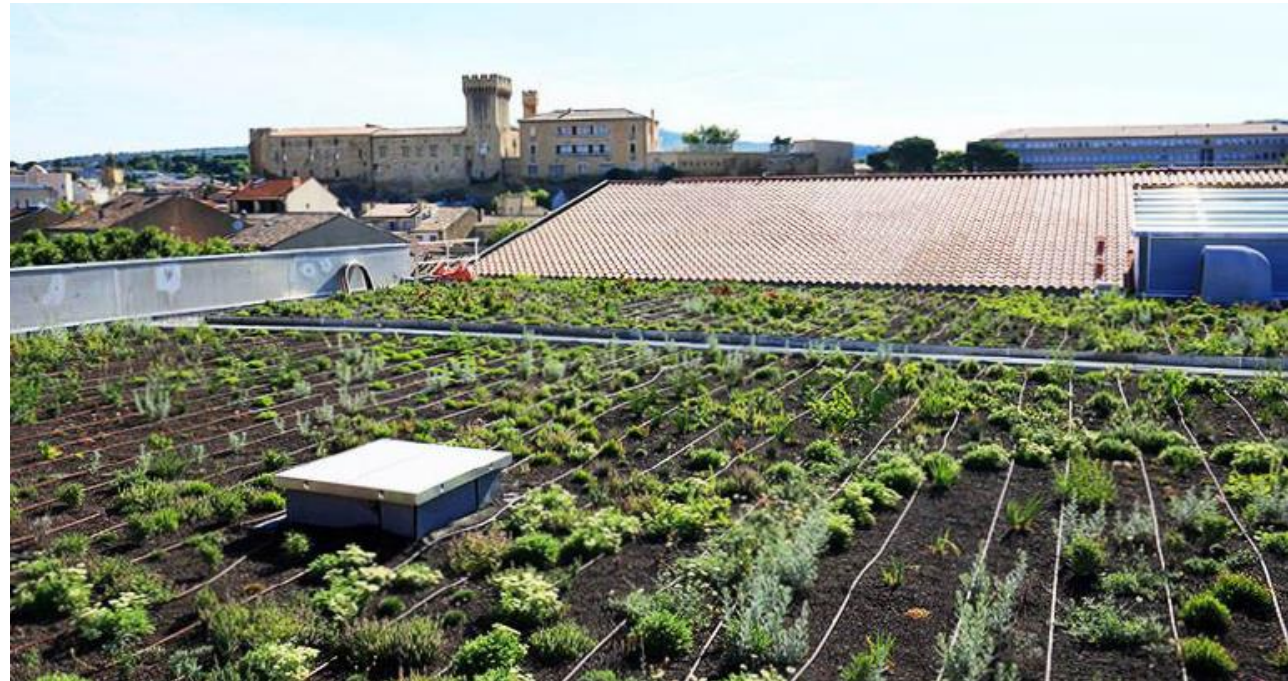
Al final de la obra
