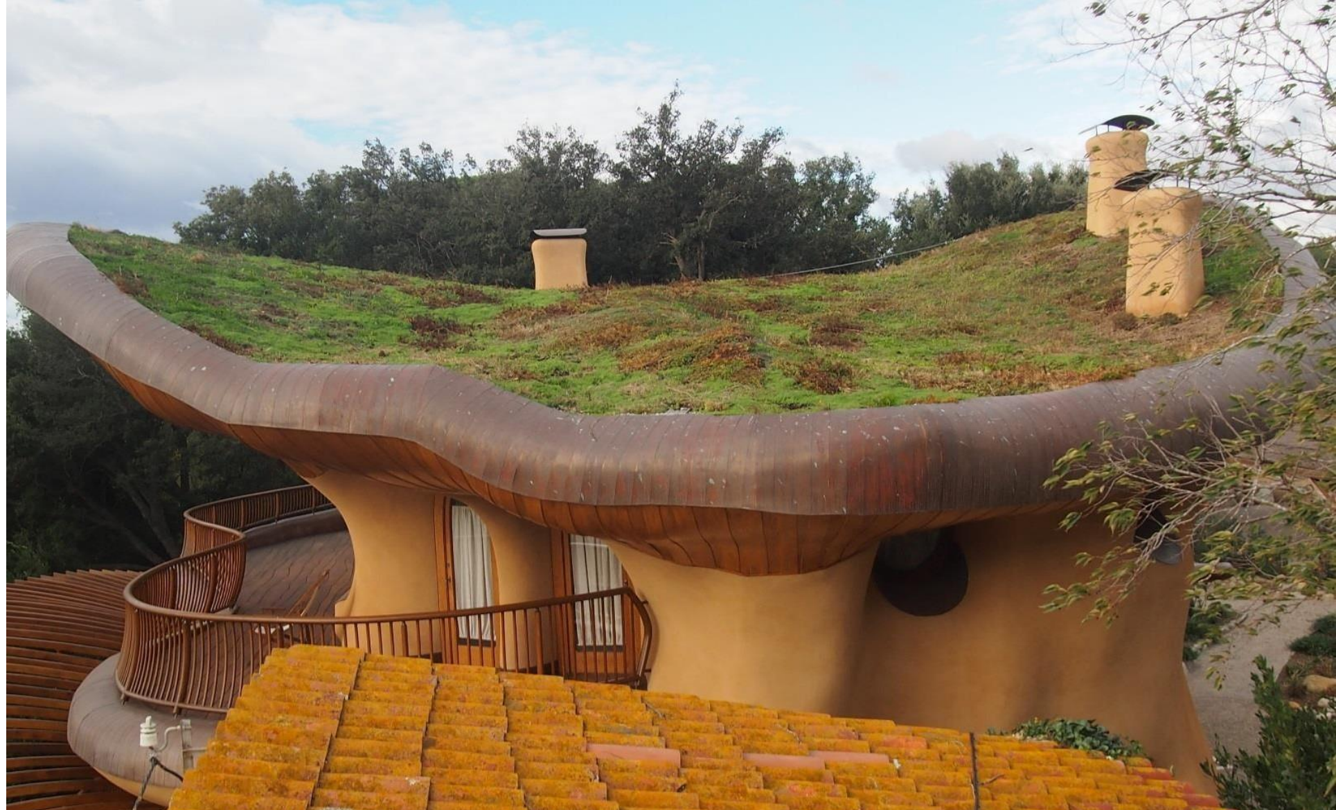
Cubierta con tepe de sedum para Vivienda. Empordà. Girona
