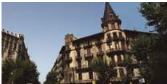
CASA BURÉS (BARCELONA). 800m 2 instalados
