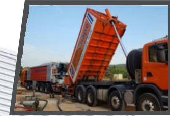
Camión de mezcla
