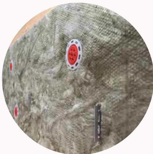
Fijación URSA TERRA Vento Plus P4203 con clavadora
