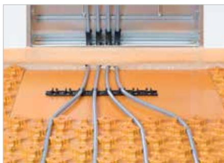
La placa lisa Schlüter-BEKOTEC-ENFG se instala delante de los colectores de calefacción para facilitar las conexiones y minimizar los cortes. Para su unión, se pega la placa de polietileno a la parte inferior de la placa de nódulos con una cinta adhesiva de doble cara (6 m), que se suministra junto con la placa.
