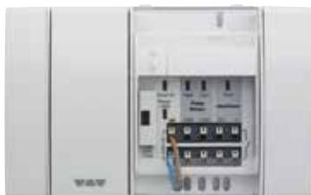
Schlüter-BEKOTEC-THERM-EBC es el módulo básico “Control” necesario para la regulación de las estancias a través de termostatos conexiónados por cable o por radiofrecuencia.
