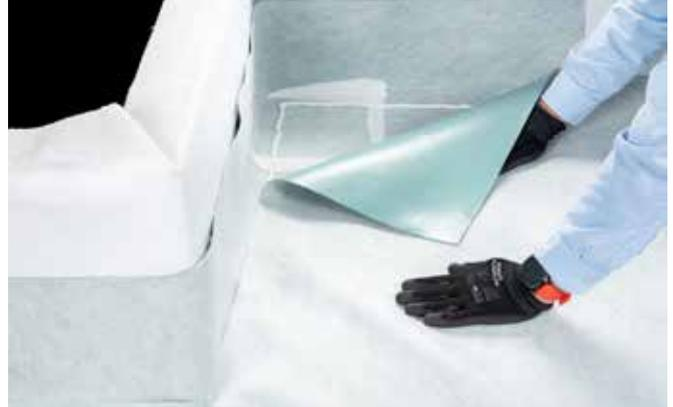
Las esquinas también se pueden realizar utilizando retales de la lámina **RENOLIT ALKORPRO** con la forma deseada, y sellada con el adhesivo **RENOLIT CEM 805**.
