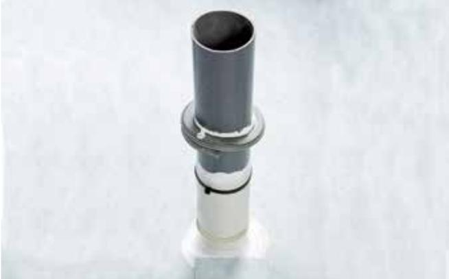
Los elementos pasantes, tales como tubos y cañerías de servicios se sellan fácilmente utilizando un manguito de PVC, la junta hidroexpansiva **RENOLIT QUELLMAX** y el adhesivo **RENOLIT CEM 805**.
