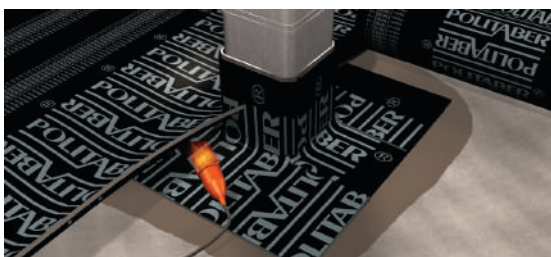
Aplicación de la membrana impermeabilizante.
