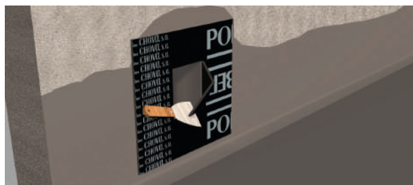
Aplicar banda de refuerzo. Adherente
