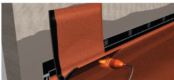
Pieza de refuerzo (superior)
