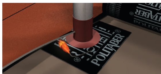
Aplicación de la membrana impermeabilizante.
