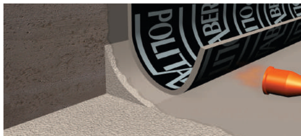
Aplicación de la banda de refuerzo.
