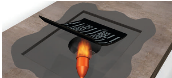
Soldar la pieza de refuerzo (inferior)
