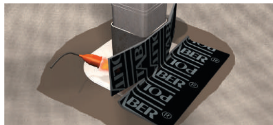
Aplicación de pieza de refuerzo inferior.
