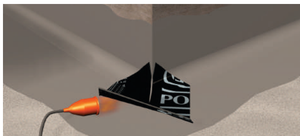
Aplicación de la pieza de refuerzo interior. Totalmente adherida.
