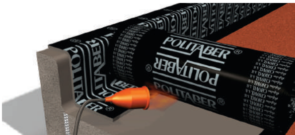
Aplicar membrana (monocapa).
