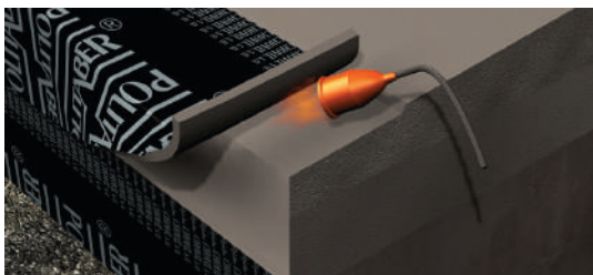
Aplicación de banda de refuerzo.
