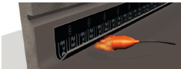
Roza imprimada. Aplicar banda de refuerzo.
