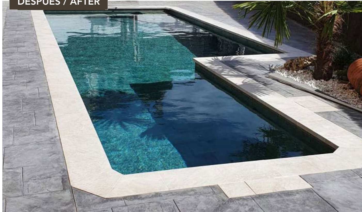
Borde rehabilitado con peldaño recto White Stone y vaso con Paradise Bali. Bases de 625x310x10 y peldaños de 625x317x10mm. Cartabón de peldaño recto y de borde de tres piezas para las esquinas de la piscina.
