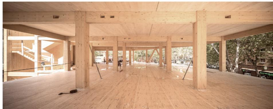
hormigón armado. Sobre rasante, se soluciona mediante estructura de madera con forjados tipo CLT y con pilares y vigas de madera laminada.
